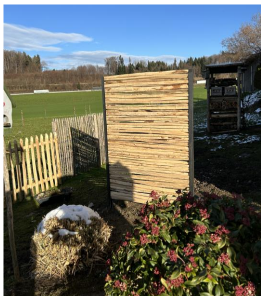
U-Profile aus Coulissenstahl 45/45/3.5mm mit Kastanienstaketen befüllt.
